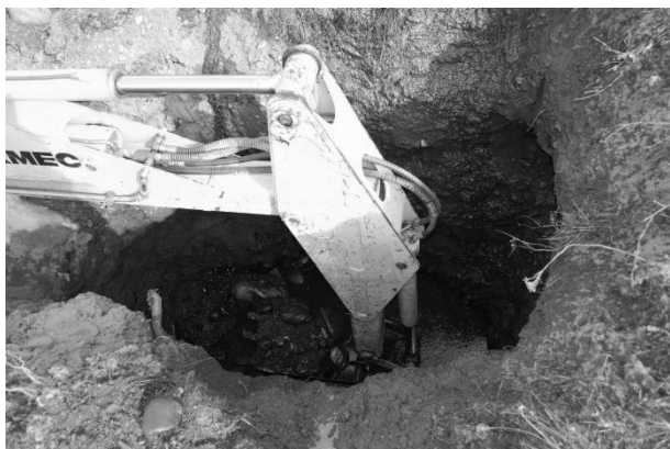
Fig. 2 Prelevare probe groapă sondare
